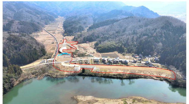
上流部無堤対策 日置地区 (令和8年3月撮影)
