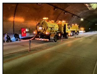
排水構造物清掃
