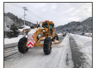
拡幅除雪 (除雪グレーダ)
