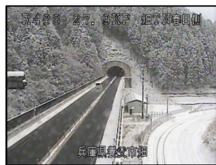
無散水融雪設備
