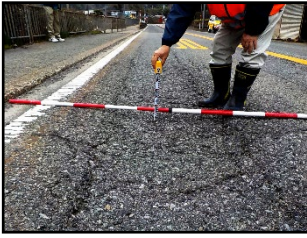
舗装（路面）点検
