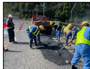
凹凸補修(パッチング)
