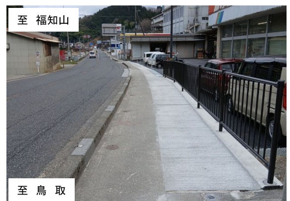
歩道拡幅により安全性を確保
