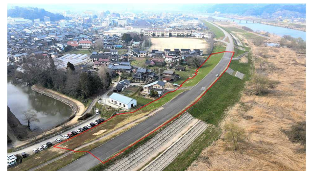
堤防強化 立野地区 (令和8年3月撮影)
