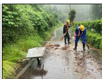
土砂流出処理
