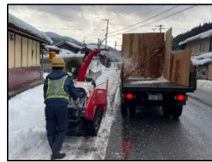
歩道除雪 (小型除雪機)
