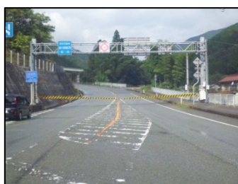
遮断機による道路通行止め
