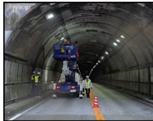
トンネル点検
