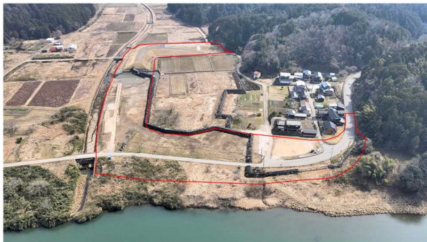
上流部無堤対策 鶴岡地区 (令和8年3月撮影)
