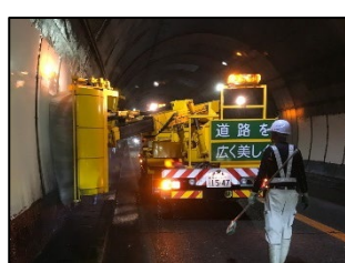
トンネル清掃
