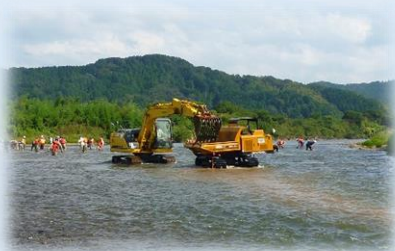
川幅が広いので重機も使って作業
