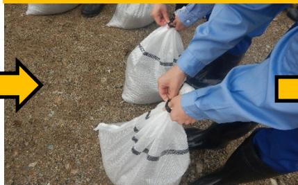
土のうを並べ、隙間埋め・滑り止めとして土砂を撒く
