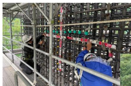
▲従来の鉄筋出来形計測
