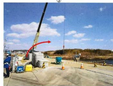
合図確認後、手前の仮置きしてあるブロックを越えながら川側へ旋回
