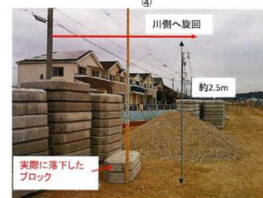
2個吊っていたブロック(180kg/個)の上の1個がバランスをくずし、約2.5mの高さから落下
