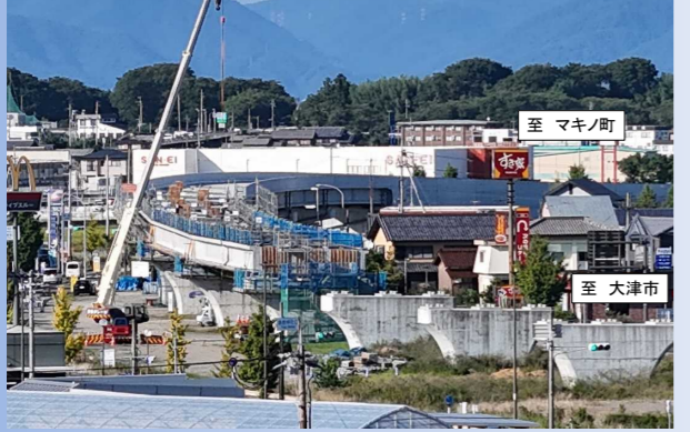
TOPICS 3 国道161号上小川北地区改良工事 R7.9月撮影
