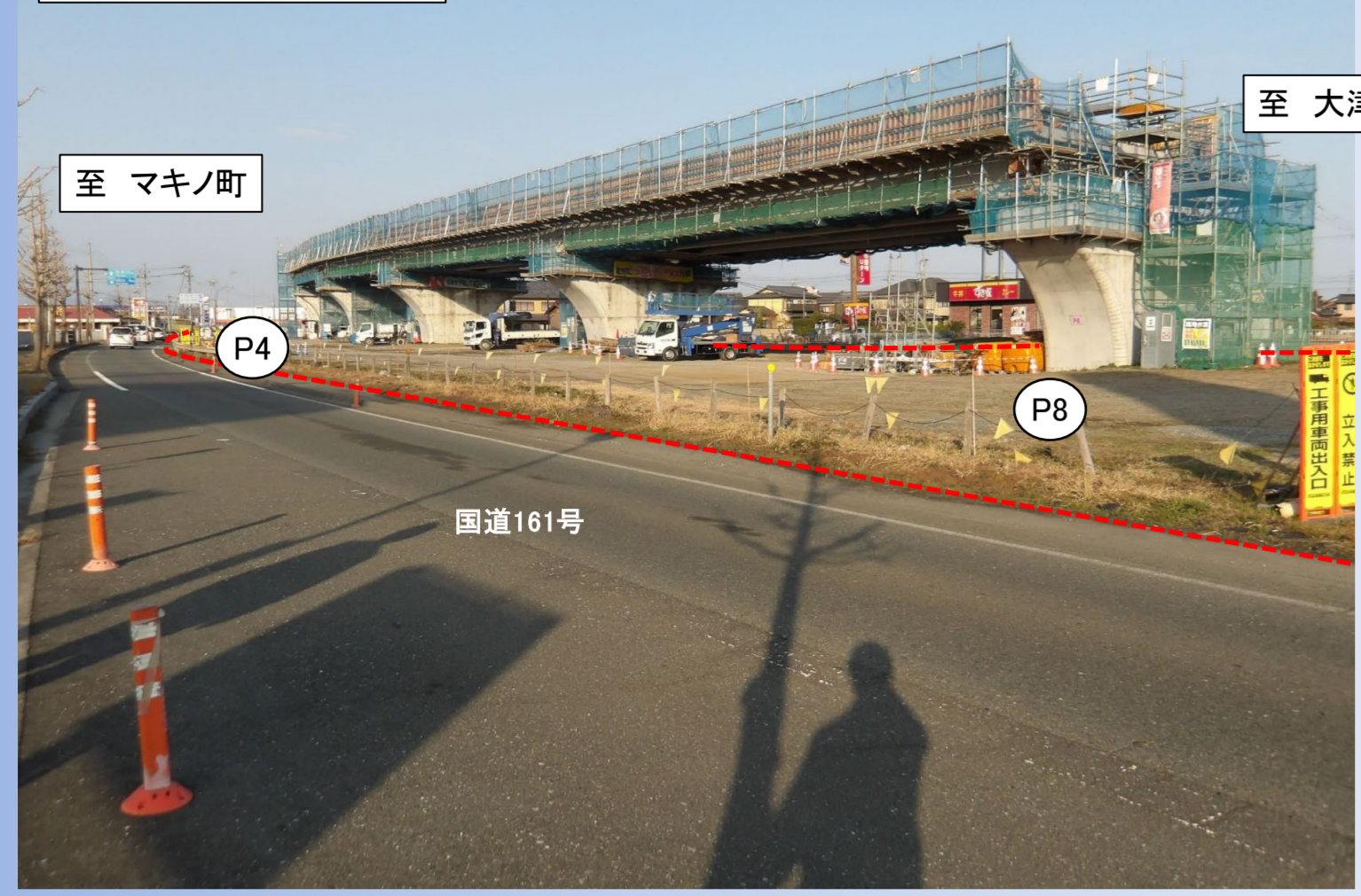
TOPICS 2 国道161号西万木高架橋(P4-P8)PC上部工事
