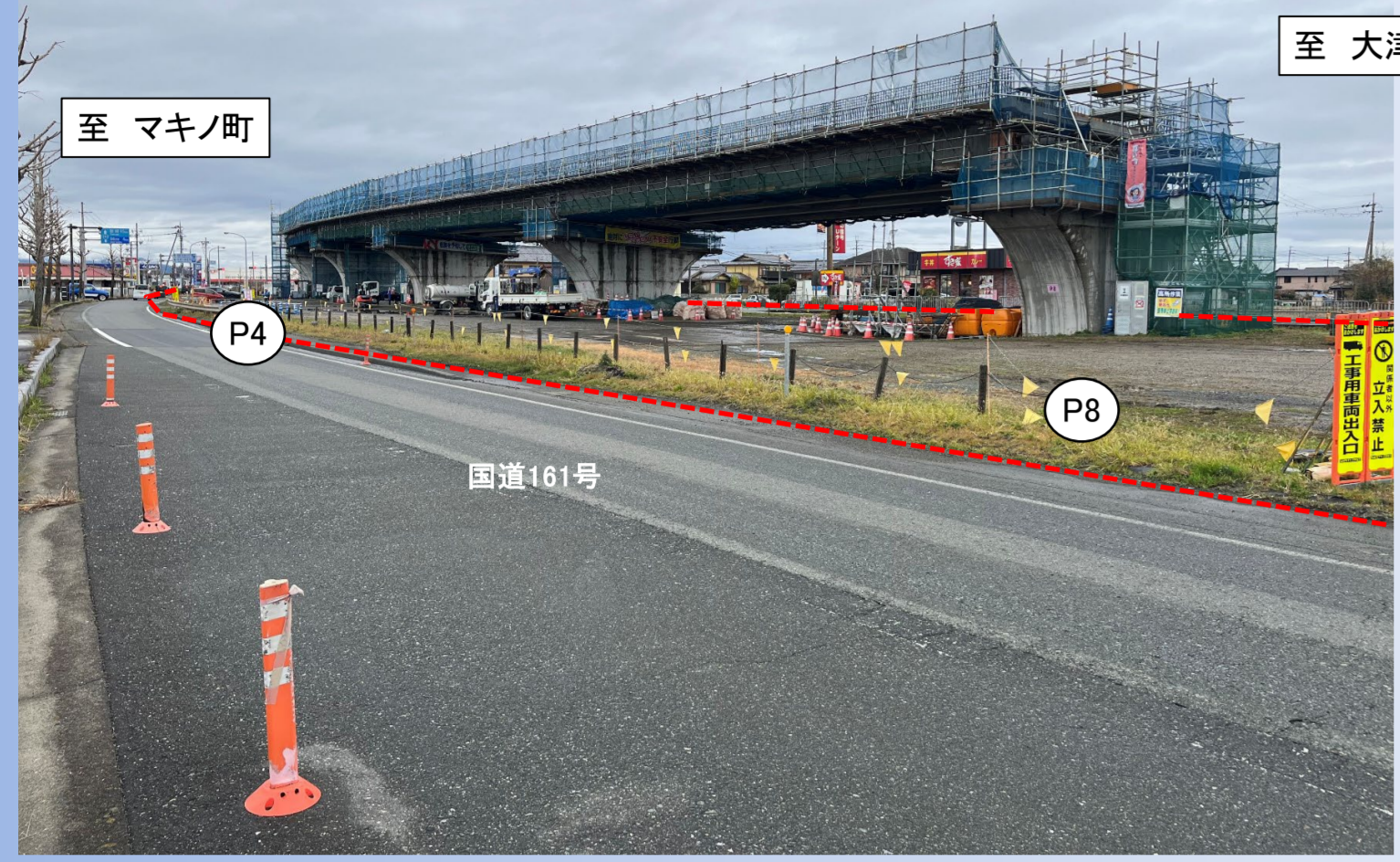
TOPICS 2 国道161号西万木高架橋(P4-P8)PC上部工事
