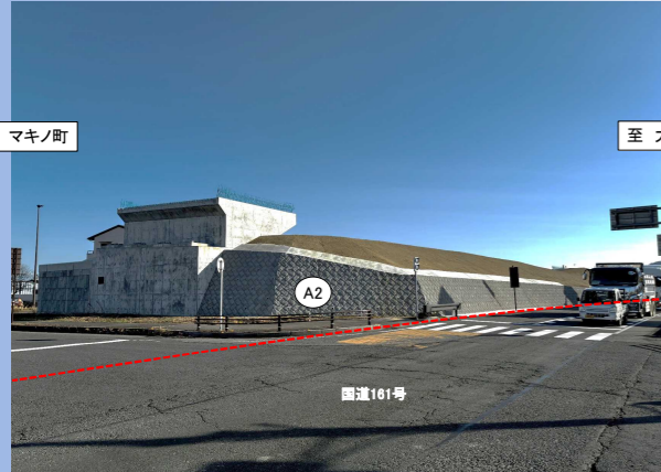
TOPICS 3 国道161号上小川北地区改良工事 R8.3月撮影
