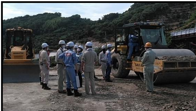
ブルドーザ(マシンコントロール) 振動ローラ(GNSSローラ) 敷均し・転圧確認
