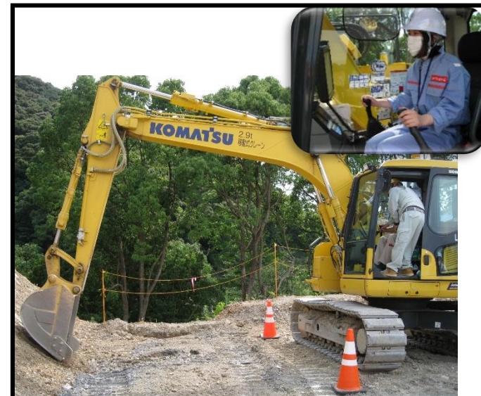
バックホウ(乗車のみ) (マシンコントロール)
