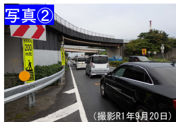
有田方面行の合流部における混雑状況
