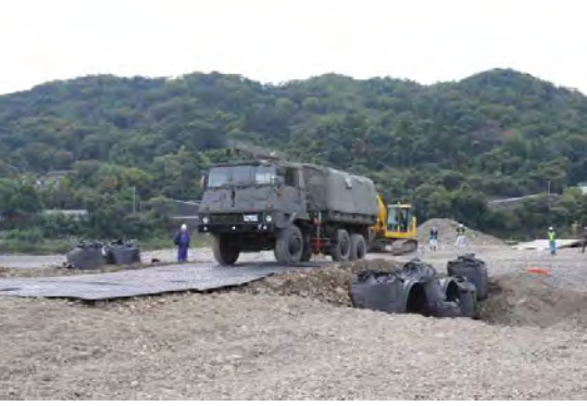
○暗渠排水管による橋梁復旧
