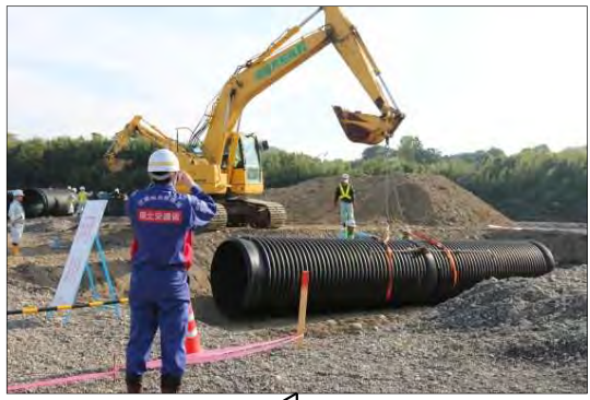
○暗渠排水管による橋梁復旧
