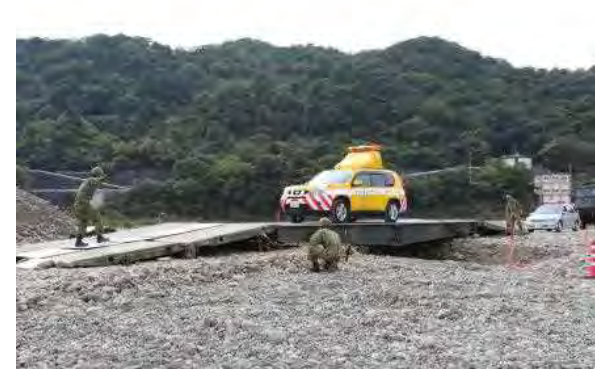
○自走式架柱橋による橋梁復旧
