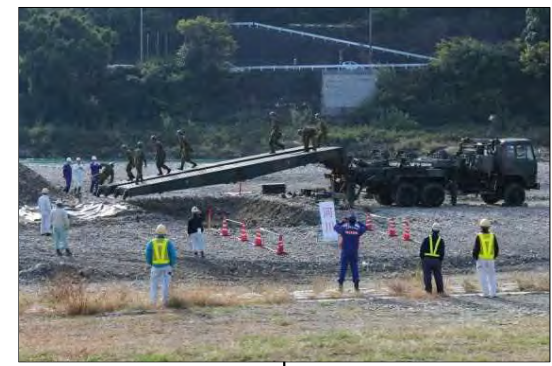
○自走式架柱橋による橋梁復旧
