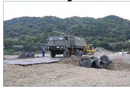
暗渠排水管等による橋梁復旧
