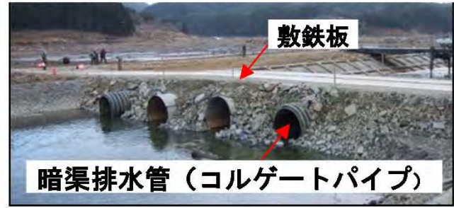
暗渠排水管等による橋梁復旧
