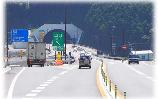
平成27年9月29日(火) 紀勢自動車道(すさみIC串本方向)
