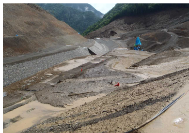
写真-1 防護土堤および仮排水路内 泥土流入状況
