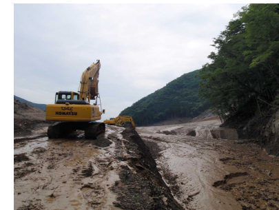
写真-5 防護土堤堆積土砂撤去状況
