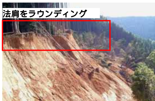
崩壊斜面上端部
