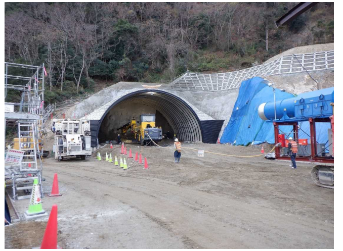
■削孔状況 【騒音振動対策：制御発破】 (令和4年12月 撮影)
