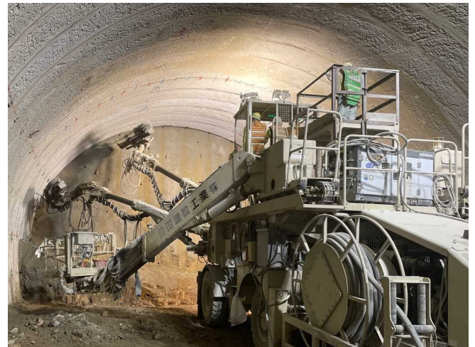
■削孔状況 【騒音振動対策：制御発破】 (令和4年12月 撮影)
