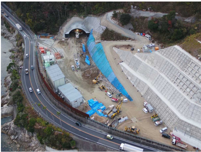
■掘削状況 【騒音振動対策：機械掘削】 (令和4年2月 撮影)
