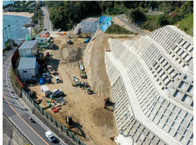
■トンネル工事着手 (令和2年11月 撮影)
