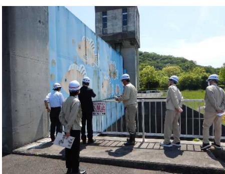
草谷川水門ゲート操作訓練
