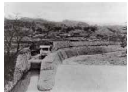
取りこわし前の山田川頭首工
