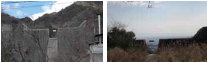
杉谷えん堤(下流側) 杉谷えん堤(上流側)
