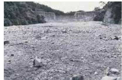
災害後(12万m 2 の土砂をためる)
