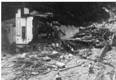
土橋駅構内 （現六甲ケーブル駅）
