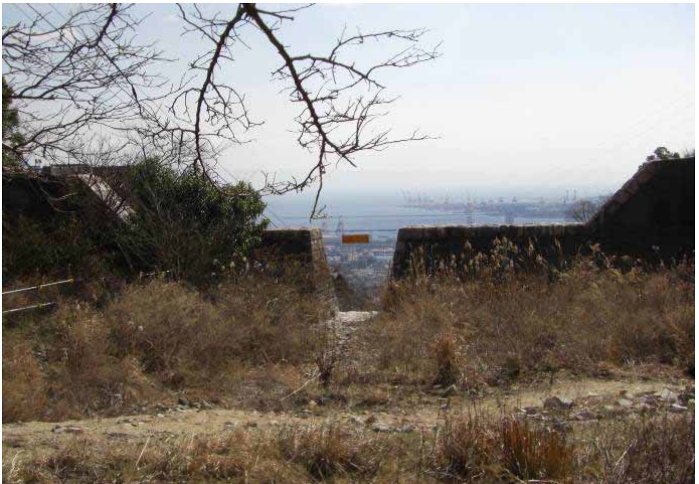
そまたに てい 袖谷えん堤
