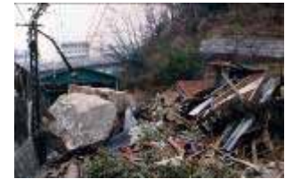
落石(六甲ケーブル)
