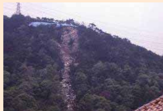
山崩れの様子(天望山)
