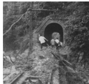
山がくずれて線路が埋まった 六甲ケーブル沿線
