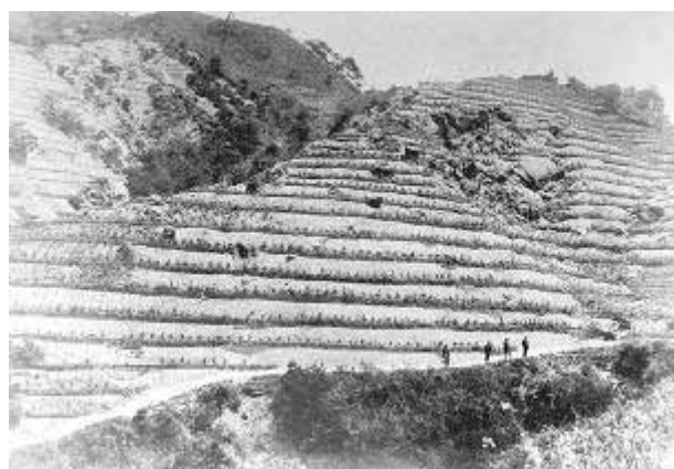
明治中期の山腹工の施工状況
