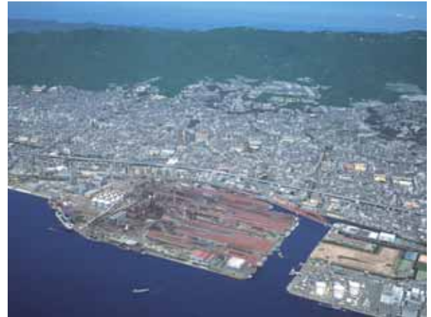
神戸製鋼所工場群
