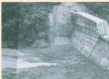
空っぽの状態 から一気に土 砂がたまった 五助えん堤の 様子
