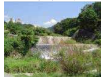
はくつる 白鶴えん堤
