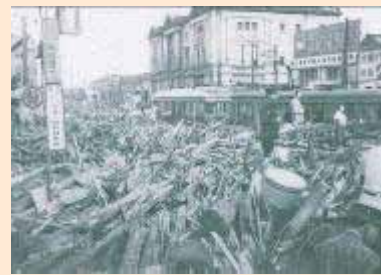
山積みされる倒壊家屋 (三越付近)
