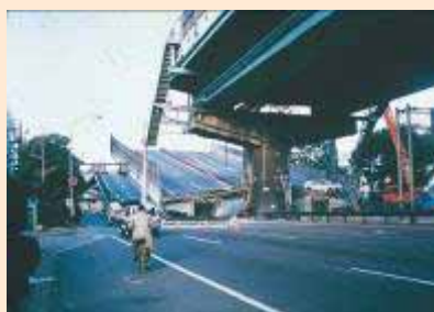
倒壊した 阪神高速
