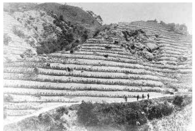
明治中期の山腹工の施工状況
