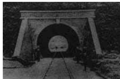
いしやがわ 石屋川鉄道トンネル
