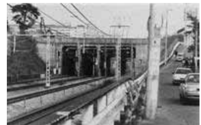
芦屋川鉄道トンネル
