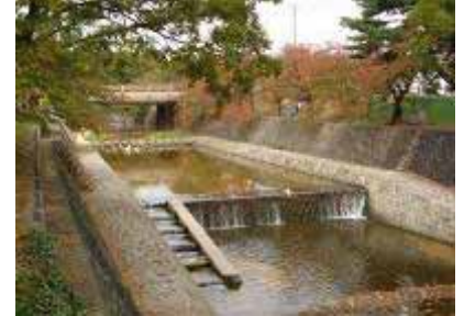
しゅくがわ なか だん さ ぎょどう 夙川の中にある段差と魚道
