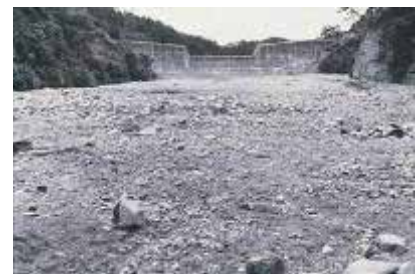
災害後(12万m 3 の土砂をためる)
