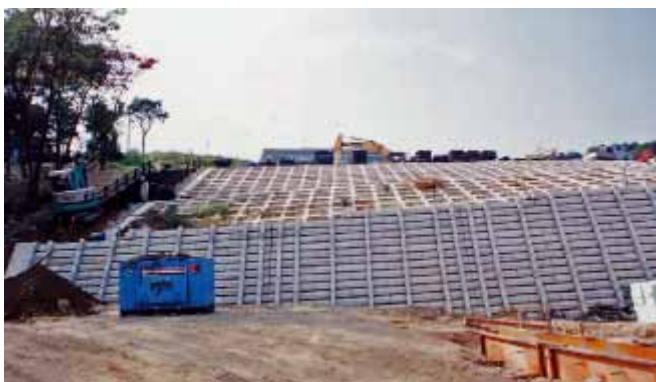
対策工事の様子
