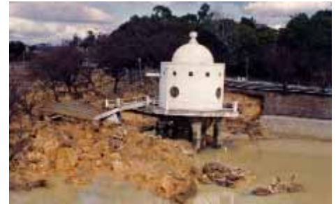
ニテコ池周辺の被害
