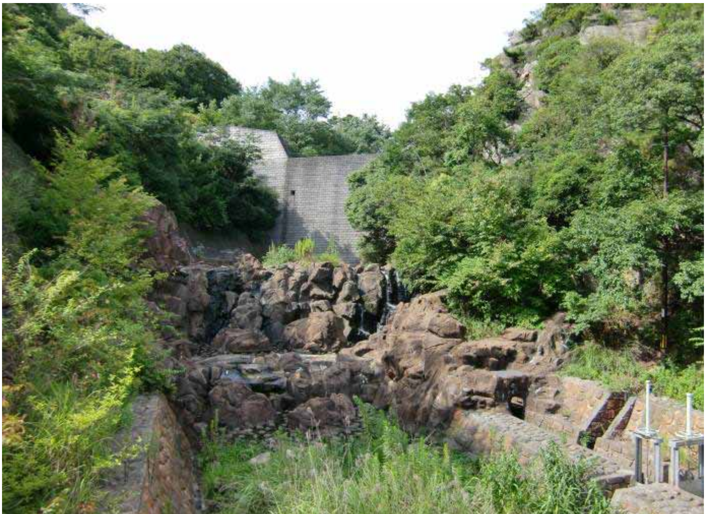
銀水橋上流付近にある水分谷えん堤
