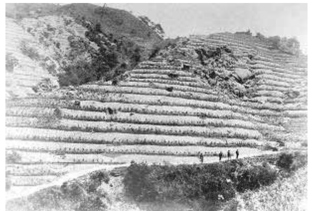
明治中期の山腹工の施工状況
