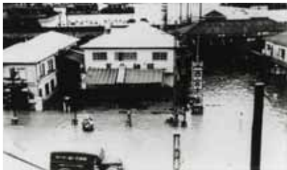
西宮市場 付近（池田町） の浸水
