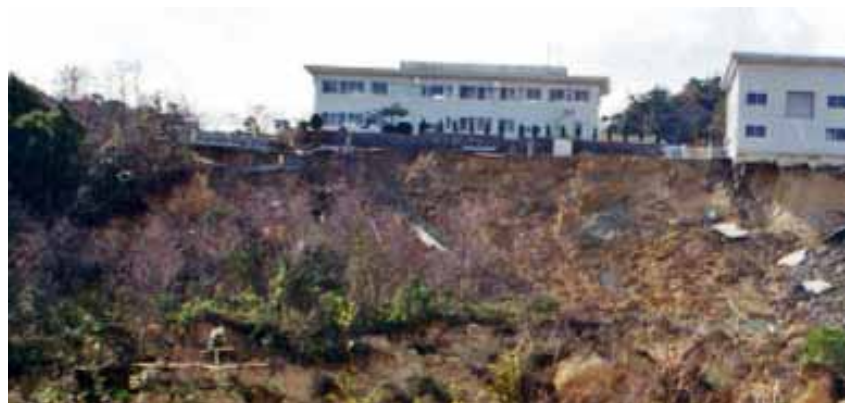
仁川百合野町のがけ崩れの様子
