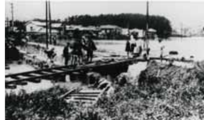
阪急甲陽線 （相生町） の軌道破損
