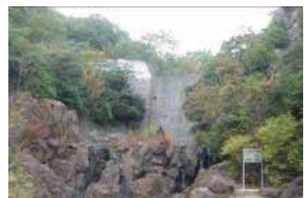
水分谷えん堤
