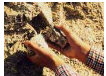
崩れやすい状態
