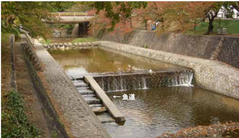
夙川の中にある段差と魚道
