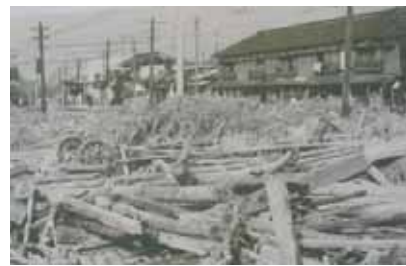
山陽電鉄 東須磨駅付近 の被災状況
