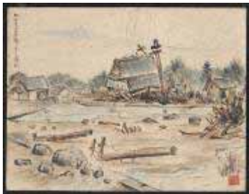
妙法寺付近 の被災状況
