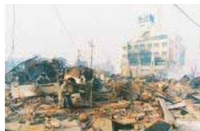
須磨区内の 被災状況
