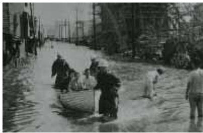
須磨区内の 被災状況 （外浜町付近）
