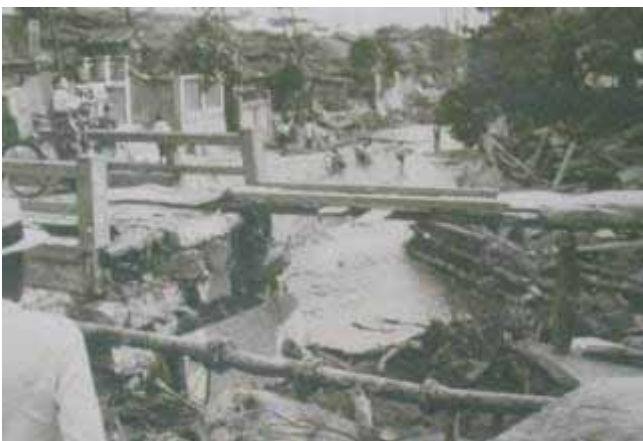
昭和13年(1938年)水害で被災した妙法寺川 (須磨区 しゅうせい 證誠神社付近)
