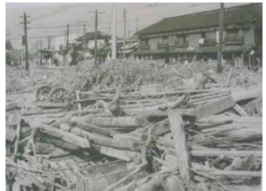
山陽電鉄東須磨付近の被害状況
