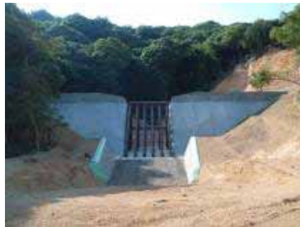
三の谷川1号えん堤(三の谷川)
