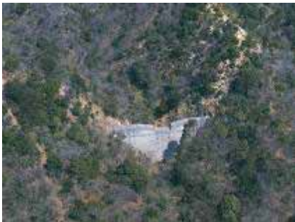
高取山第二えん堤
