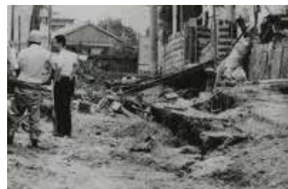
須磨区内の 被災状況 （天井川付近）
