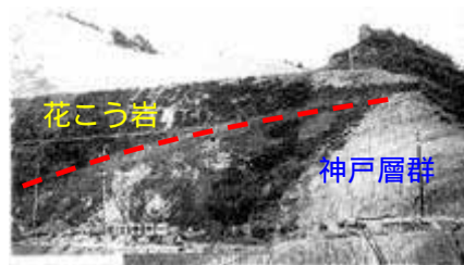
高取山断層の断層 (昭和50年:1975年)
