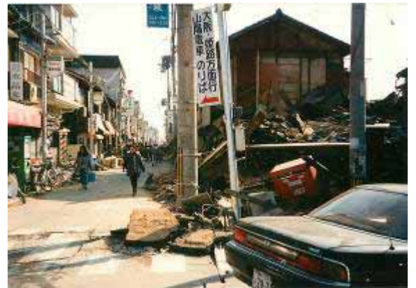
須磨寺商店街付近の被災の状況
