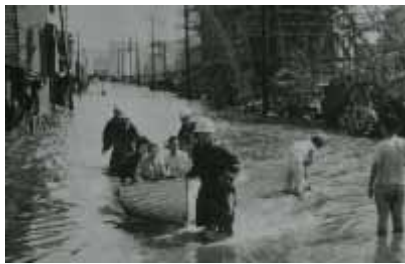
須磨区内の被災状況 (外浜町付近)
