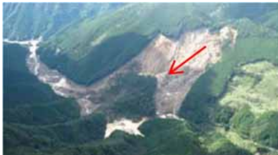
和歌山県田辺市熊野での土砂災害(平成23年:2011年)
