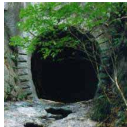
土砂水を迂回させるためのトンネル
