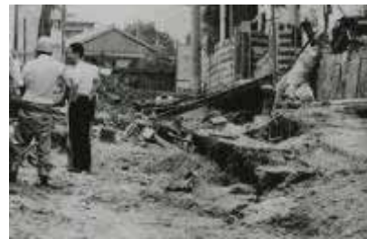
須磨区内の被災状況 (天井川付近)
