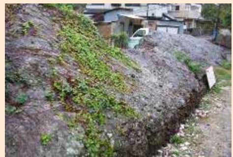
神戸層群の礫岩層(妙法寺付近)
