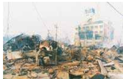
須磨区内の被災状況
