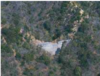
高取山第二えん堤
