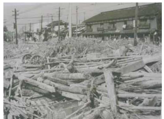
山陽電鉄東須磨付近の被害状況
