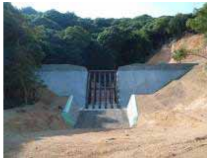
三の谷川1号えん堤(三の谷川)
