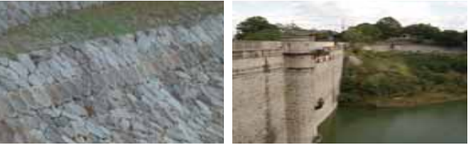
護岸に埋め込まれた石臼 鳥原貯水池のえん堤
