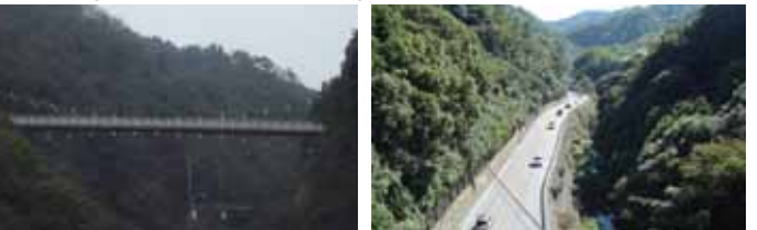
天王吊橋 天王谷川と有馬街道
