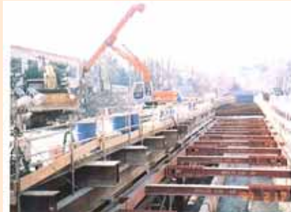
夢野橋下流付近の河川工事 (出典: 新湊川流域変遷史)
