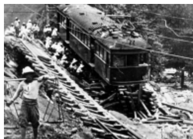
土石流に押し流された 神有電鉄 (現・神戸電鉄)の車両
