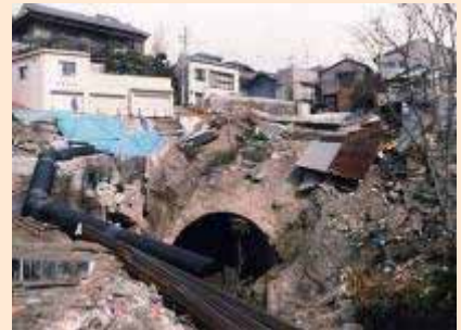
トンネル出入口周辺の土砂くずれ (出典: 阪神・淡路大震災誌)
