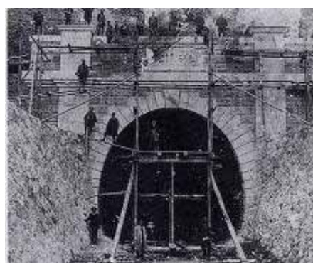
工事の様子(出典:神戸市制100周年)
