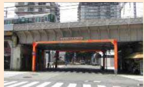
現在の様子(鉄道トンネルがあった辺り)
