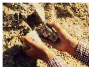
崩れやすい状態
