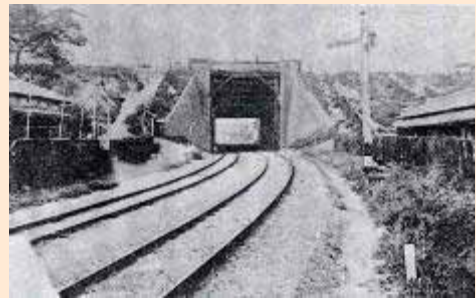
天井川である旧湊川の鉄道トンネル (出典:海鳴りやまず)
