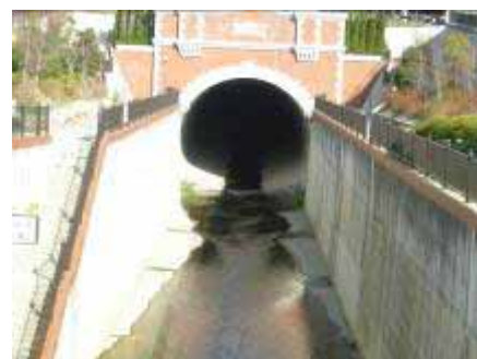
現在の湊川隧道(会下山トンネル)
