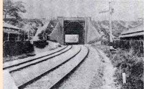
天井川である旧湊川の鉄道トンネル (出典:海鳴りやまず)
