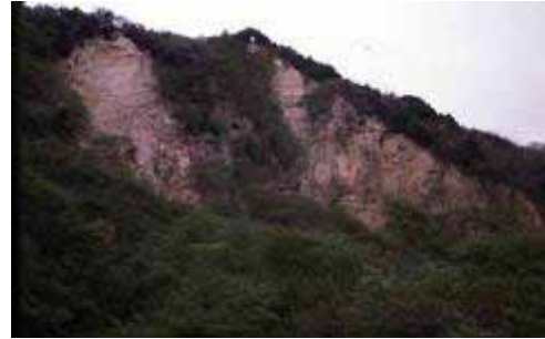
土砂が崩れた場所
