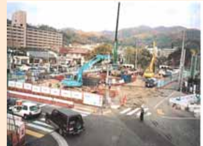
菊水橋架け替え工事 (出典: 新湊川流域変遷史)
