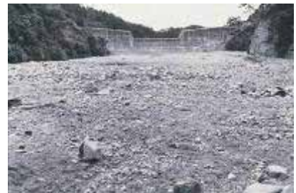
災害後(12万m 2 の土砂をためる)
