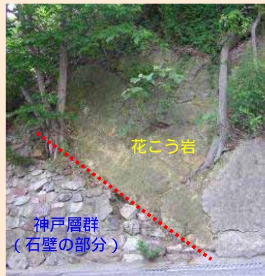
丸山衝上断層の断面（現在の様子）
