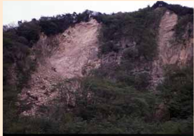
山崩れの様子(菊水山城ヶ越東側)
