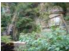
めんたき しゅすい てい しゅすい しせつ ■雌滝取水えん堤・取水施設
