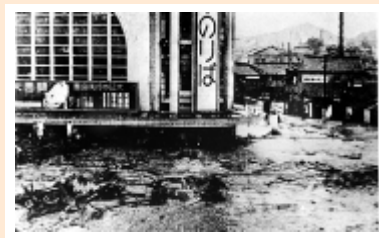
だくりゅう 濁流にのまれた三ノ宮駅周辺
