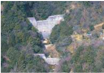
新市ヶ原えん堤
