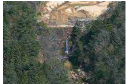
はっしゅうれい 八洲嶺えん堤
