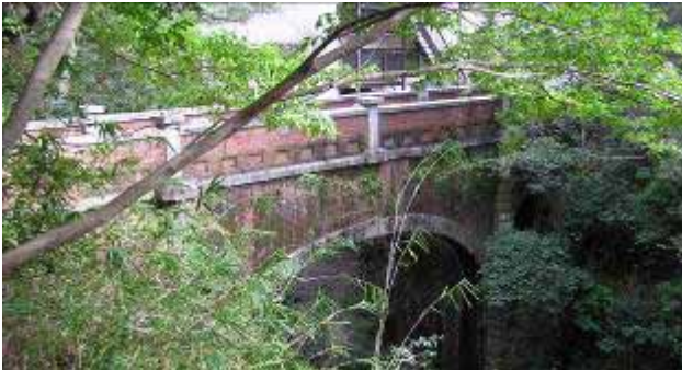
内部に配水管がある砂子橋
