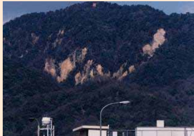
山崩れの様子(芋川谷地区)
