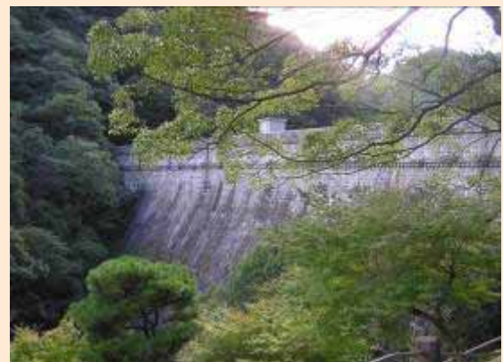
布引五本松えん堤
