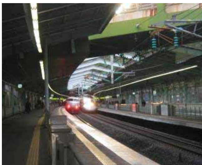
新神戸駅構内(中央の建物)の様子
