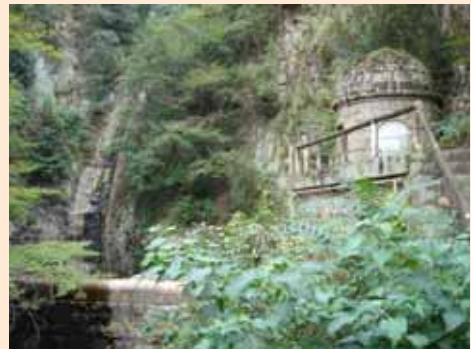
雌滝取水えん堤及び取水施設
