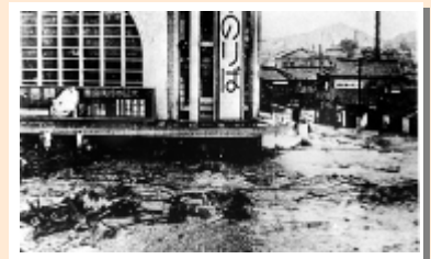
だくりゅう 濁流にのまれた三ノ宮駅周辺
