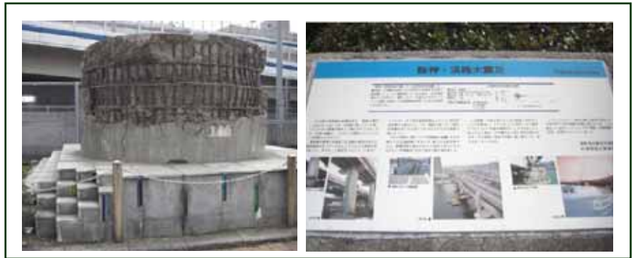
「被災した橋脚」 新港町(国道2号の歩道)
