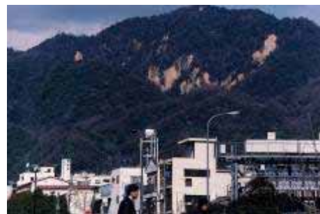
土砂が崩れた場所
