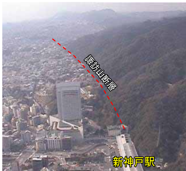
新神戸駅周辺の様子
