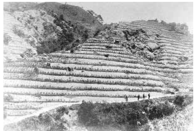
明治中期の山腹工の施工状況
