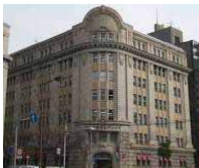
旧居留地5番館商船三井ビル
