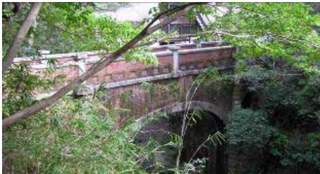
内部に配水管がある砂子橋
