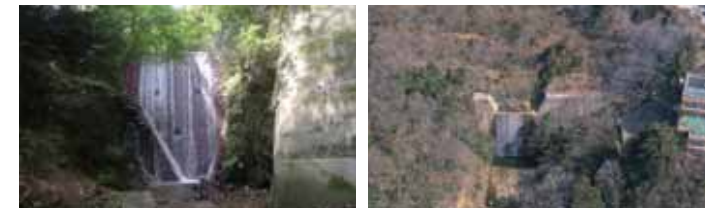
高座えん堤 城山えん堤
