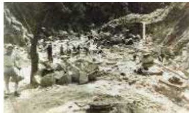
材料の切り出し・基礎造り
