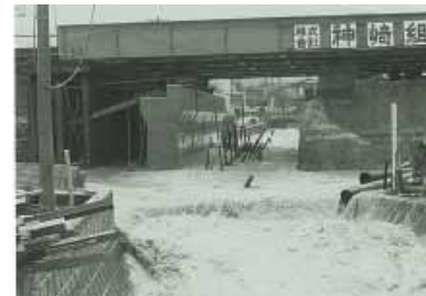
濁流に洗われる 上宮川町付近
