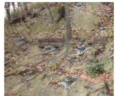
アンカーという鉄の棒で、山はだ を押さえつけて守っています。
