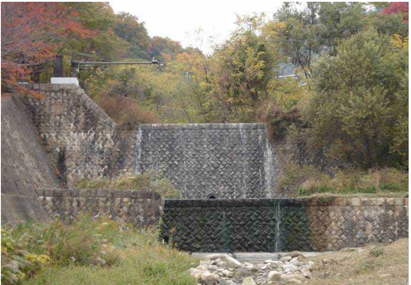
山芦屋公園より上流付近にある芦屋川の砂防えん堤
