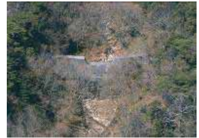
椿谷第二えん堤
