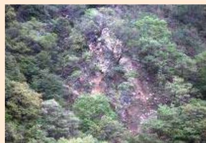
山崩れの様子 (芦屋川沿いのハイキングコース)
