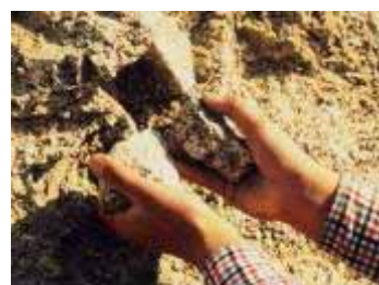
崩れやすい状態
