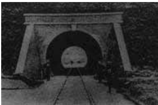
石屋川鉄道トンネル
