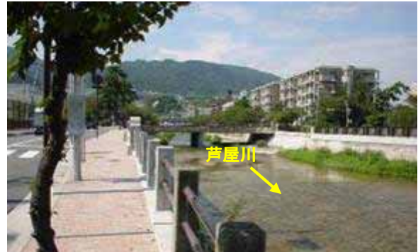
トンネルの上を流れる芦屋川の様子
