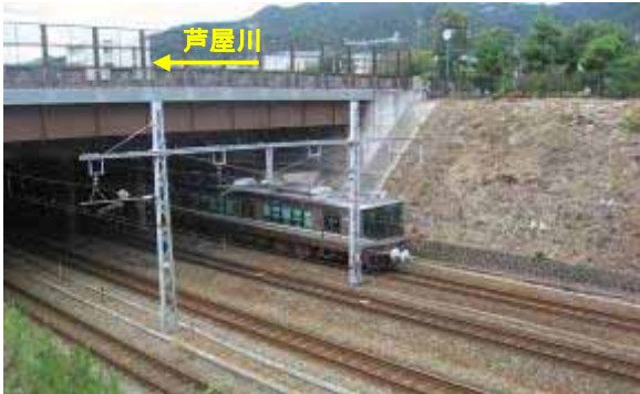
芦屋川トンネル(JR東海道本線)
