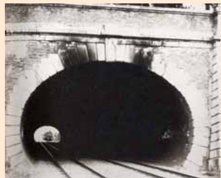
レンガ積みの芦屋川トンネル(複線)
