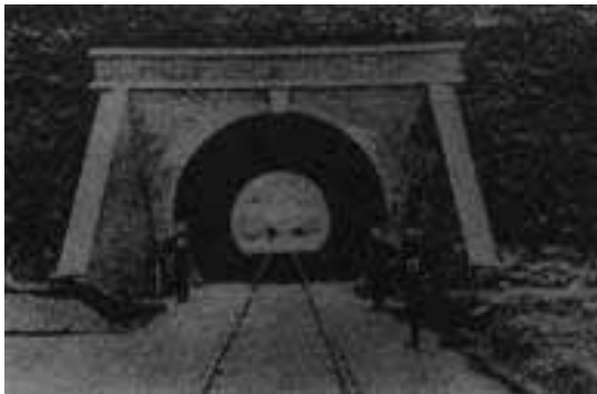
石屋川鉄道トンネル
