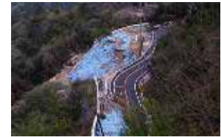
道路沿いの土砂崩れ
