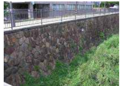
河川護岸(芦屋川)
