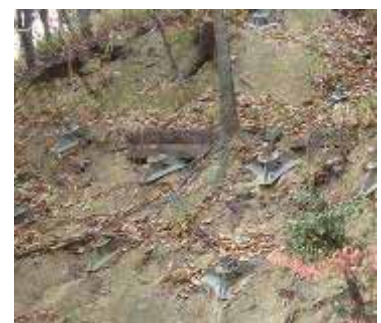
アンカーという鉄の棒で、山はだ を押さえつけて守っています。
