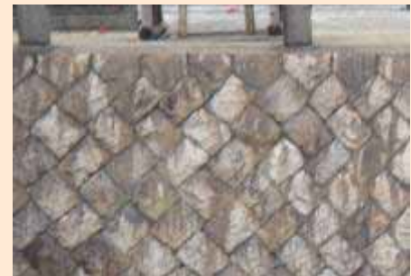
左岸(改修後の石積)
