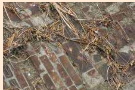
再利用された芦屋川トンネルのレンガ
