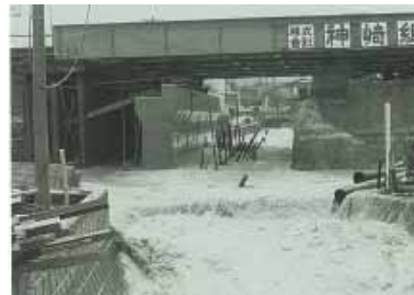
濁流に洗われる 上宮川町付近
