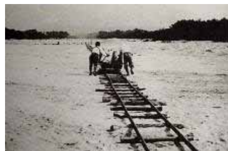
大正初期の芦屋川改修工事の風景
