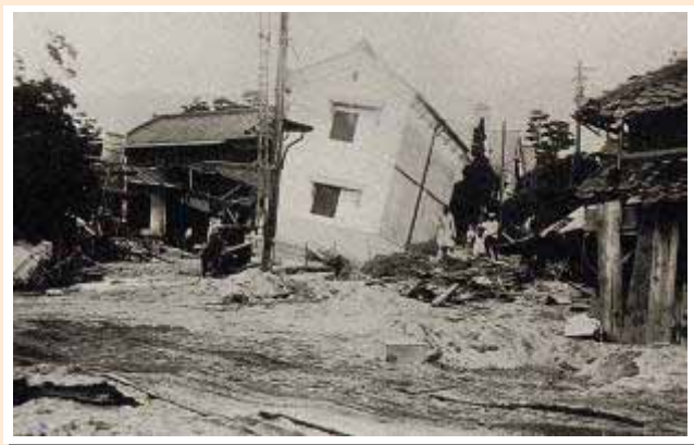
水の流れて傾いた土蔵（芦屋川駅北側付近）
