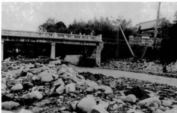
有馬川中流での被害(山口町：明治橋付近)
