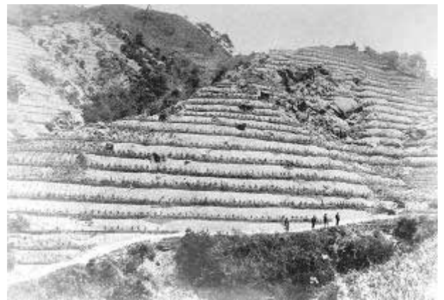
明治中期の山腹工の施工状況
