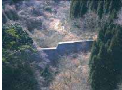
白石第二えん堤
