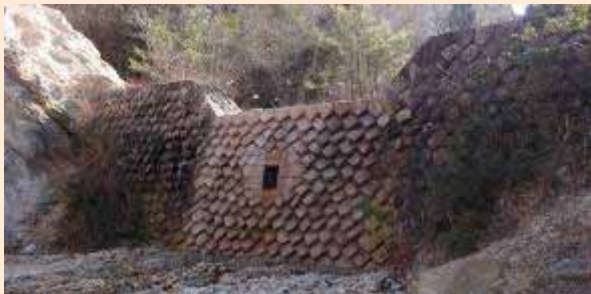
白水峡付近の砂防えん堤
