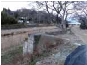
① コンクリートの橋台
