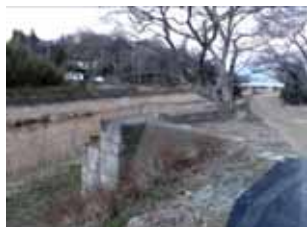
① コンクリートの橋台
