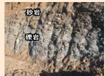
神戸層群 (桃源洞付近の工事現場にて撮影:平成24年(2012年)12月)
