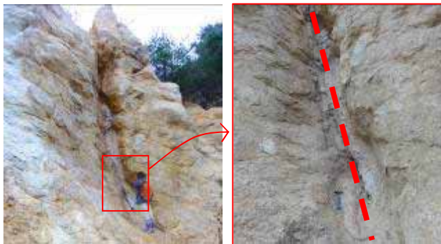
県道51号線沿いで確認できる花こう岩中の断層の様子
