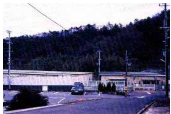
仮設住宅(有馬住宅)
