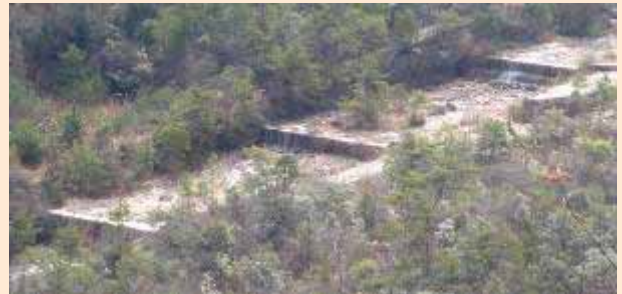
蓬萊峡付近の砂防えん堤
