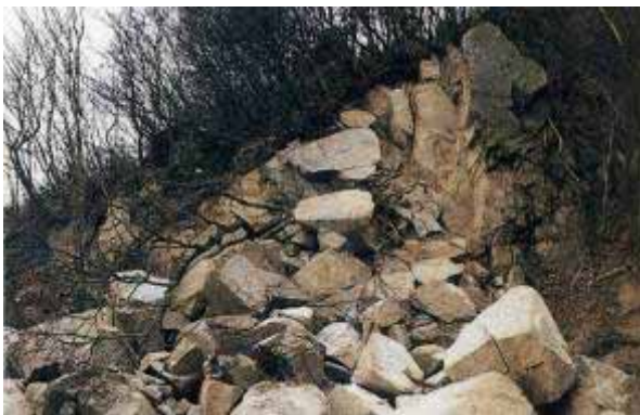
後鉢巻下谷 うしろはちまきしもだに のがけ崩れ くづ
