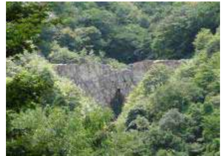
みょうげんだに 妙見谷えん堤
