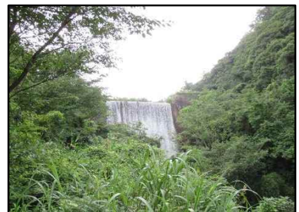
五助砂防堰堤
