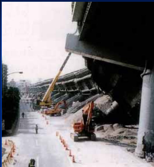
倒壊した阪神高速道路
