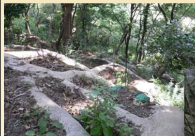
現存植生を 保全した法枠工
