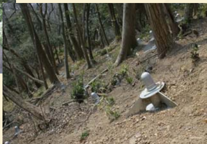
鉄筋挿入工法
