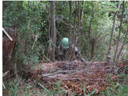
東側斜面整備②
