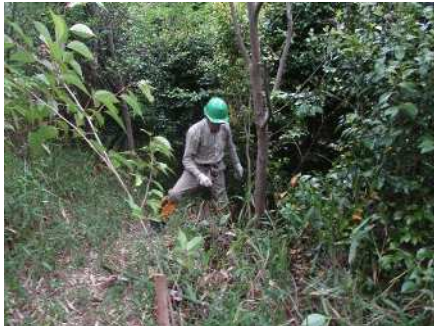
東側斜面整備①
