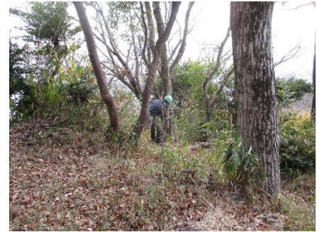
南西斜面整備
