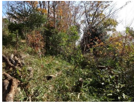
西側斜面整備 after①
