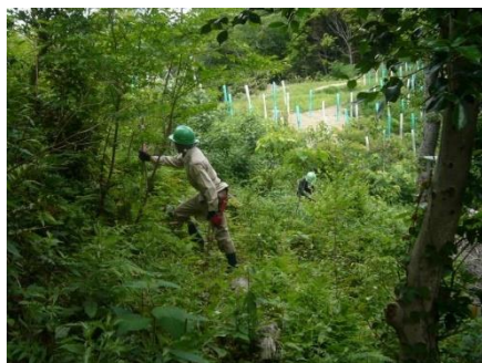
東側斜面整備
