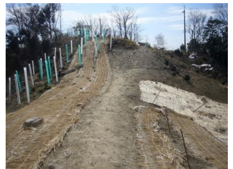
登山道復旧状況
