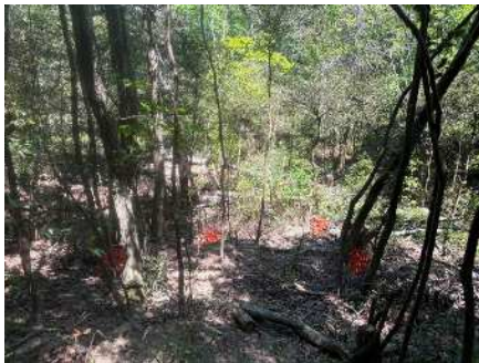
保護ネット取付け後 全体
